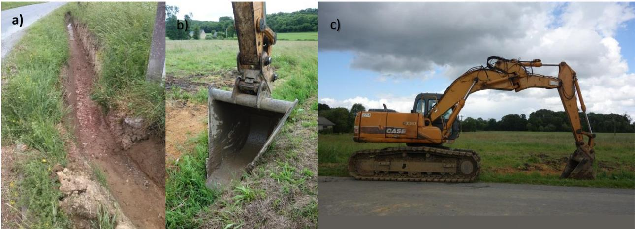
Figure 5. a) Fossé ayant subi un curage b) Godet trapézoïdal servant à redonner au fossé son profil originel c) Tractopelle à bras déporté avec un godet trapézoïdal servant au curage de fossé
